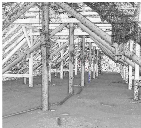
Laserpunktwolke | Dachstuhl TenneTennelerei | STADTVERMESSUNG ©
