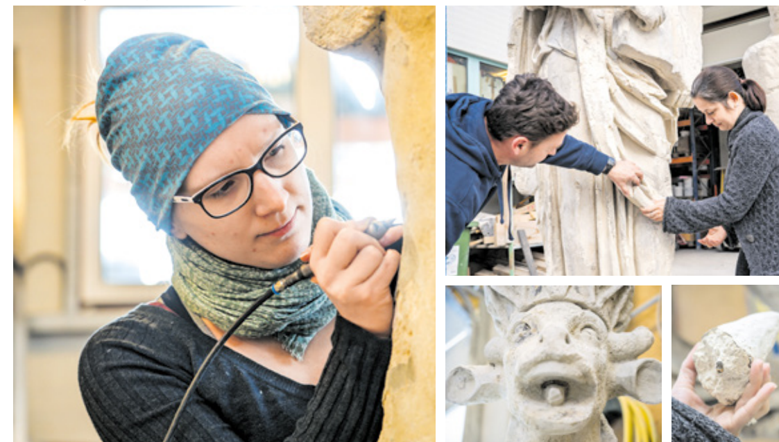
Vom Fach. Bildhauerin Raffaella Heilig entfernt den Zement mit einem Makromeißel. Oben: RestauratorIn Jenny Pfeifruck-Vass (für den Befund zuständig) & Lorand Vass. Unten: Der Panther erhält wieder sein rechtes Horn.
