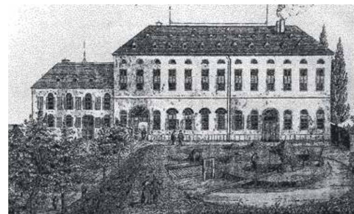
Imposant. Die Zuckerraffinerie in der Herdergasse – Heinrichstraße.
