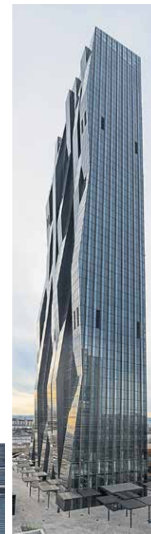
Stahl aus Graz hält den 250 Meter hohen Wiener DC Tower zusammen.
