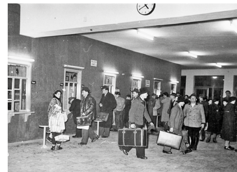
Der 1944 bombenzerstörte Hauptbahnhof wurde 1955 als Neubau eröffnet. Damals spielte die „Kleine Halle“ eine wichtige Rolle. So ganz anders als heute waren Kleidung und Gepäck. Erst wenige Jahre konnte man ohne technische und rechtliche Probleme reisen.
