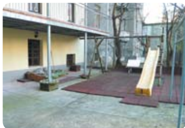
Zustand vor der Revitalisierung
