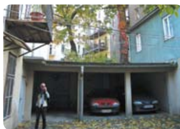
Hofeinbauten: Neu errichtete oder unlängst sanierte Hofeinbauten stellen auf Jahre einen unveränderlichen Bestand dar.
