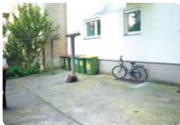
Zustand vor der Revitalisierung
