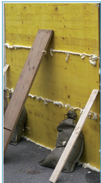
Behelfsmäßiger Gebäudeschutz mit PU-Schaum (Montageschaum) und Doka-Platten
