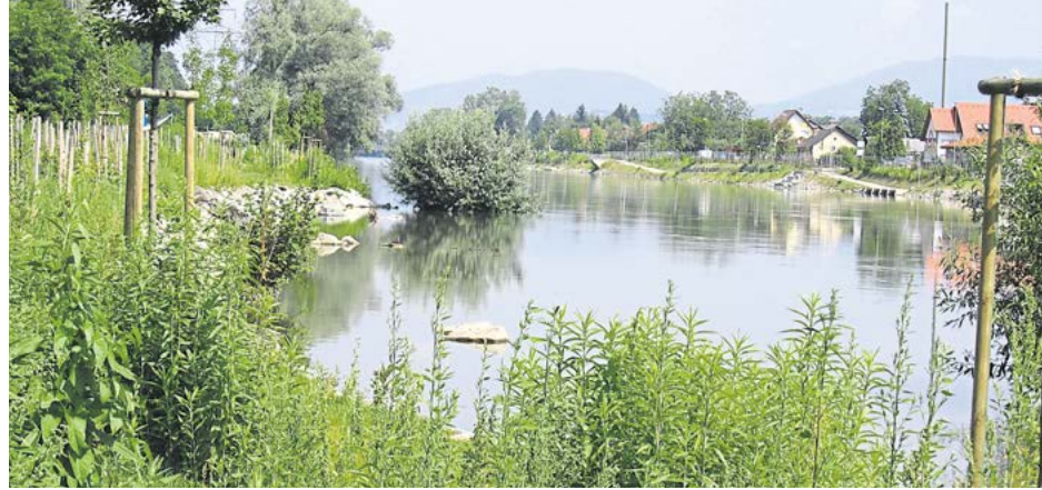
Kostbares Grün. Das Murufer im Süden von Graz, Bereich Murfelderstraße.
