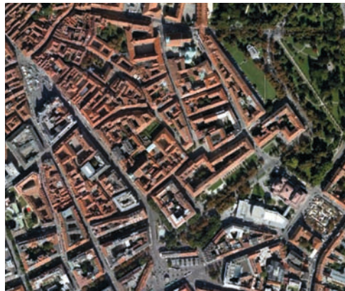
Abbildung 16: Die Klasse „Gebäude“ im Innenstadtbereich (MUICK 2011)
