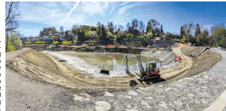
Schutzzone. Mit der laufenden Begrünung des Dammes wird das riesige Rückhaltebecken am Petersbach demnächst weitestgehend funktionstüchtig sein.
