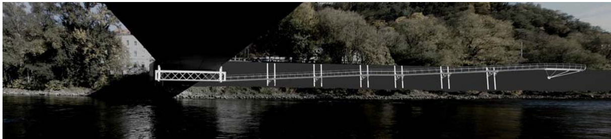
Abb.2: Ansicht vom gegenüberliegenden Murofer
