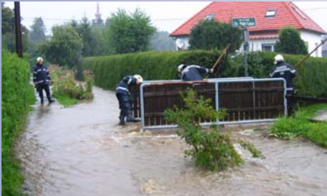
Verklaute Brücke am Petersbach beim Hochwasserereignis im Jahre 2005.
