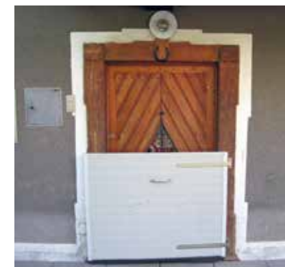
Mobiler Objektschutz für Haustüre in St. Peter.
