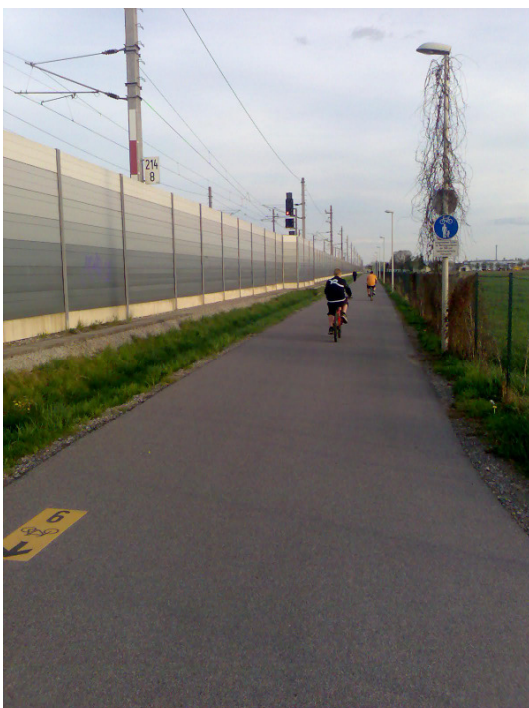
Foto 5: Gemischter Geh- und Radweg außerhalb des Zentrums
