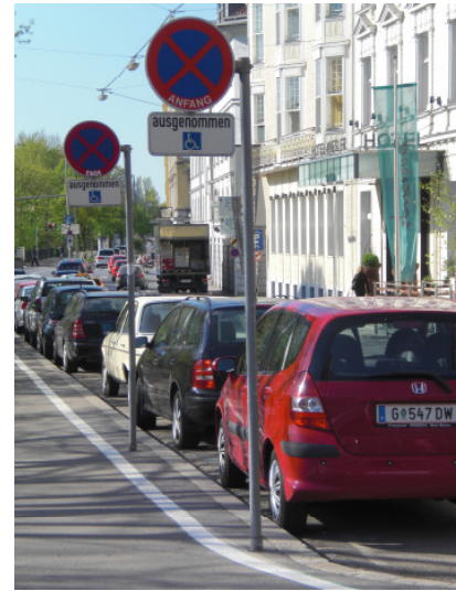
Foto 1: Exzentrisch montierte Verkehrszeichen neben einem Geh-Radweg
