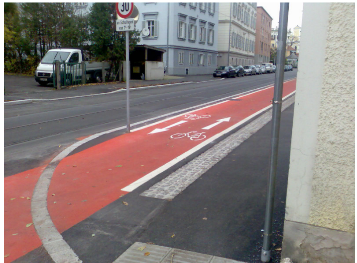
Foto 8: Getrennter Geh- und Radweg mit taktiler Trennung und roter Beschichtung
