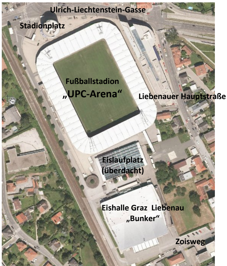
Abb. 1: Luftbild – Eishalle Graz Liebenau, überdachter Eislaufplatz und UPC-Arena Quelle: Geodaten Stadt Graz, Einträge StRH
