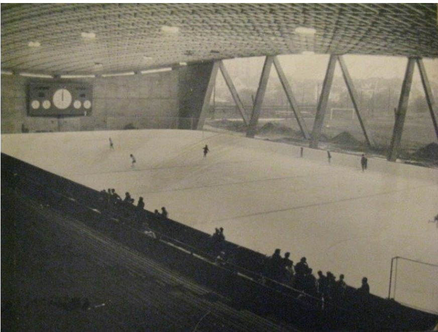
Abb. 4: Eishalle (nach Norden offen) mit den „A-Säulen“ und eingehängter Holz-Kassettendecke Quelle: Bericht GBG
