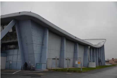
Ansicht Ost - Stahlbetonoptik
