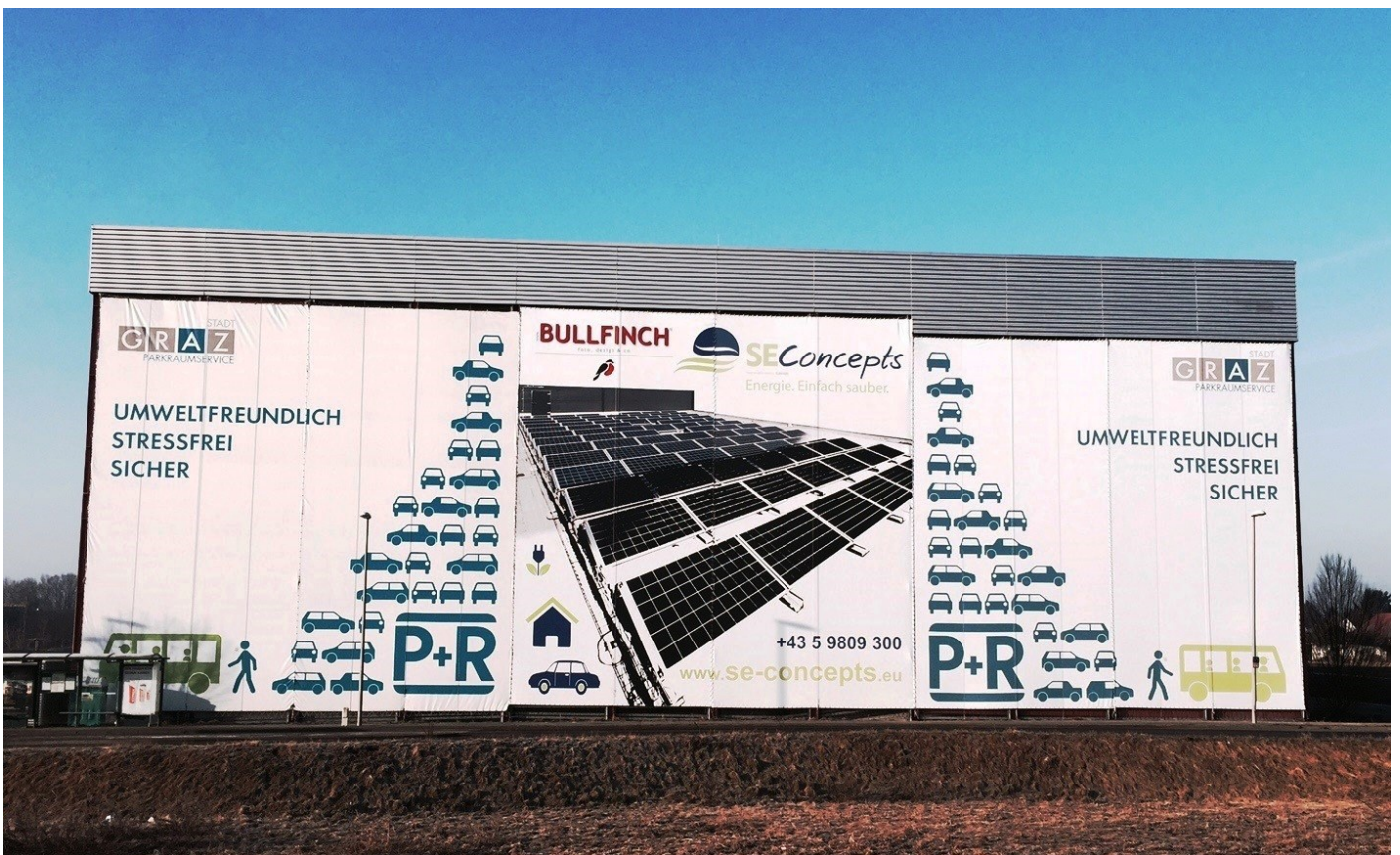
Errichtung und Inbetriebnahme der Photovoltaikanlage am 4.800m 2 – Dach/P+R Thondorf in Zusammenarbeit mit SEC Concepts GmbH, GBG, Immobilienabteilung der Stadt Graz und GPS.
