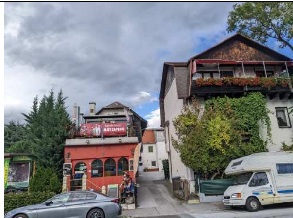
Abbildung 13: Blick auf Bereich Nr. 2, Münzgrabenstraße Richtung Osten
