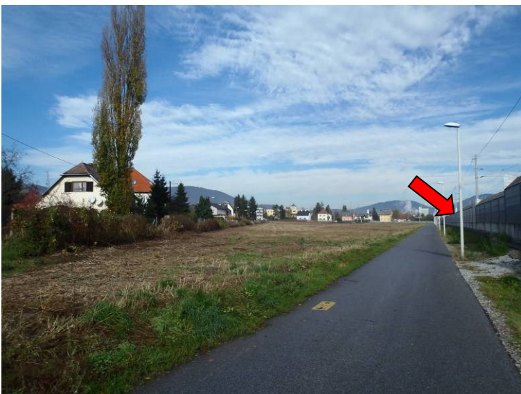
Foto 1: Blickrichtung Norden: Begleitstraße (Fuß- und Radweg) an der ÖBB – Trasse und Lärmschutzwand (s. roter Pfeil).
