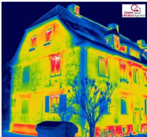
Thermografie vor Sanierung
