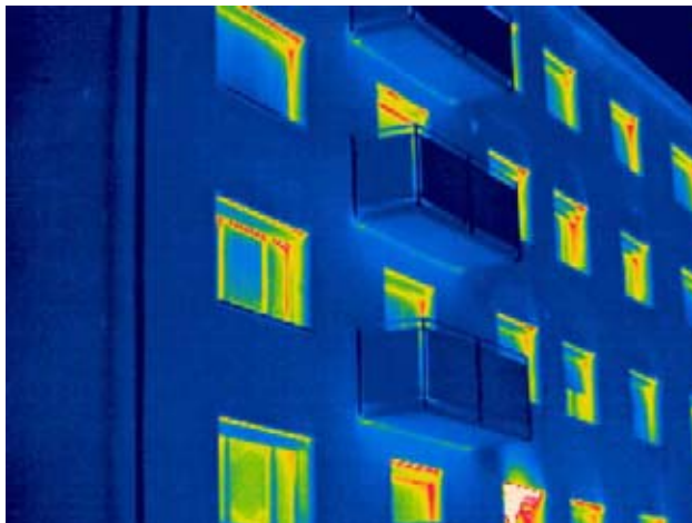
Thermografie nach Sanierung
