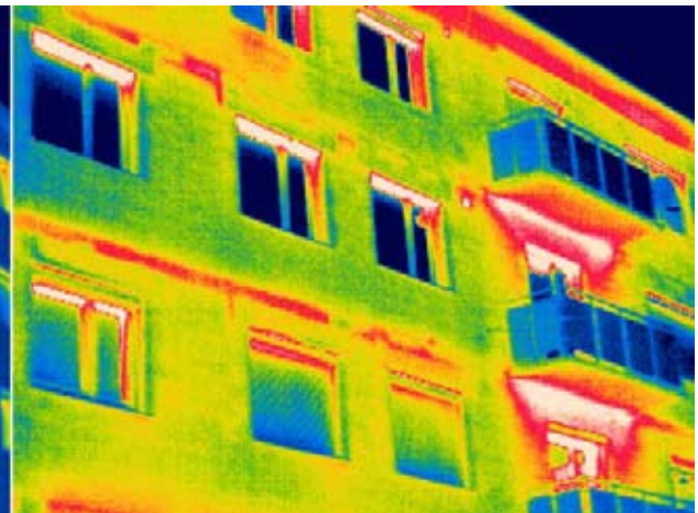
Thermografie vor Sanierung
