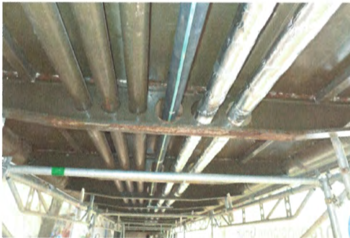
Untersicht Zugangsbrücke linkes Ufer
