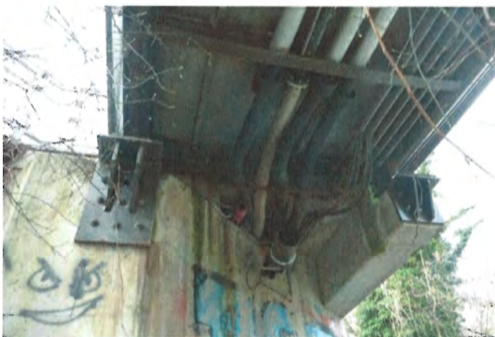
Auflagerbereich Rampe rechter Uferbereich
