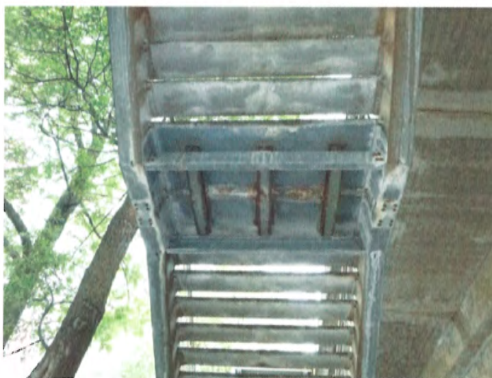
Untersicht Stiegenabgang, Linkes Ufer
