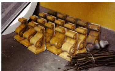
Es sind massive Schäden in Form von Putzabplatzungen u.a. an den Gesimsen, Fensterstürzen, Kapitellen, Scheingiebel, wie auch Risse festzustellen, das NF-Ziegel-Mauerwerk ist punktuell freiliegend. Etliche Gesimsekonsolen fehlen bzw. haben sich gelöst.
