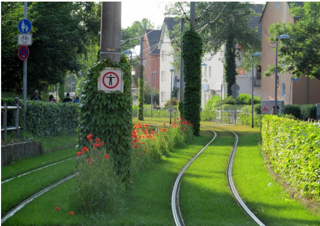
Foto 8: Rasengleis in Freiburg mit „gärtnerischer Gestaltung“ (Foto: Pro Bim Graz, Udo. W. Häberlin)
