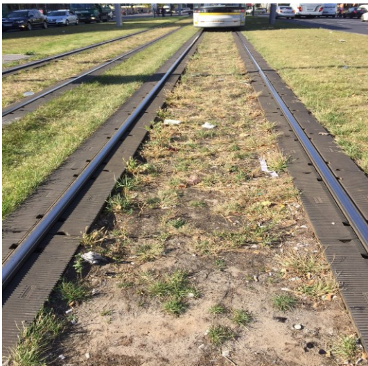
Foto 1: Berlin Hauptbahnhof, Eröffnung Sommer 2015, Schienenummantelung, keine Bewässerung
