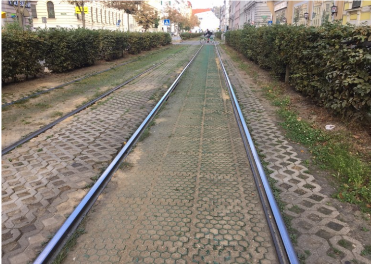
Foto 3: Graz Linien 4/5 Conrad-von-Hötzendorfstraße / Landesgericht, Folgen intensiver Befahrung durch Busse, Einsatzfahrzeuge, Müllabfuhr, ...
