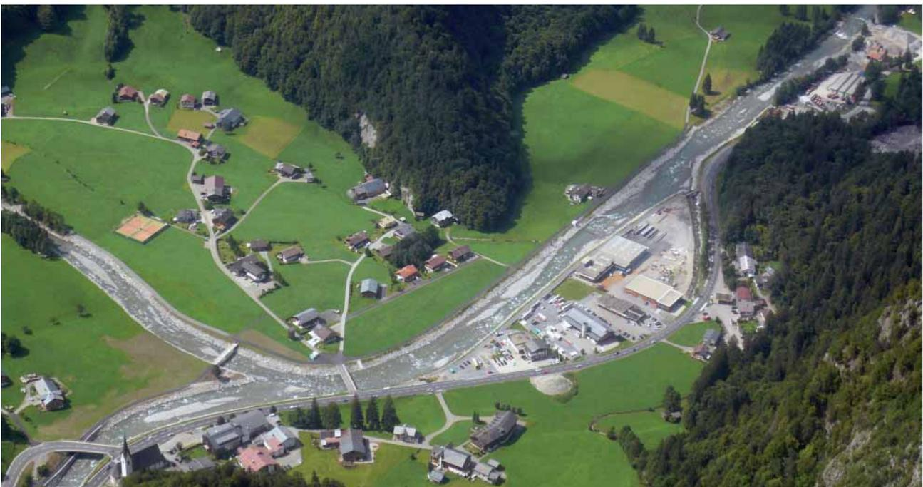
▲ Die Bregenzerach im Bereich Au mit der Mündung des Argenbaches (li.). In mehreren Bauabschnitten wurde der vom Hochwasser 2005 stark betroffene Fluss aufgeweitet, sodass er 100-jährliche Hochwässer schadlos abführen kann.
