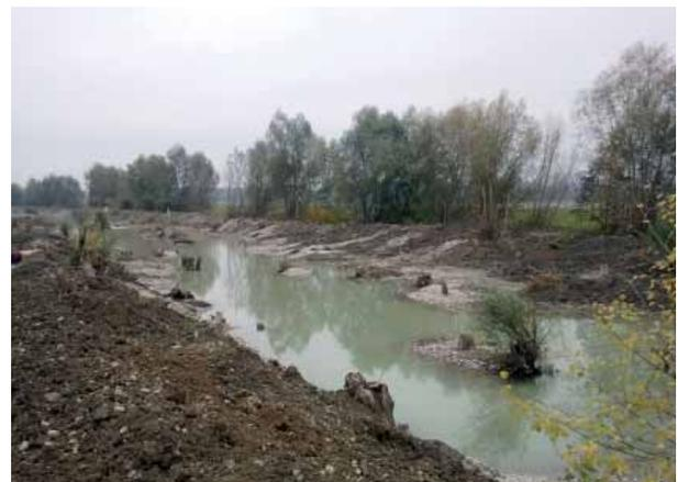
▲ Die neue Flutmulde bringt viele Vorteile: Materialgewinnung für den Bau der Schutzdämme, Abfuhr kleinerer Hochwässer, Erhaltung des Au-Charakters und Fischaufstieg seitlich des Kraftwerks Wallsee/Mitterkirchen.
