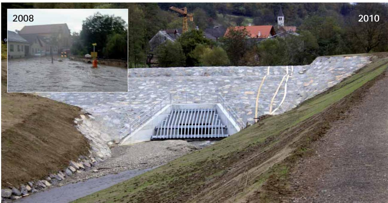
▲ Ein Rückhaltebecken, errichtet in nur zwei Jahren Planungs- und Bauzeit, schützt seit 2010 den Ort Kobersdorf. 2008 hatte eine Flutwelle schwere Zerstörungen angerichtet (kleines Bild).
