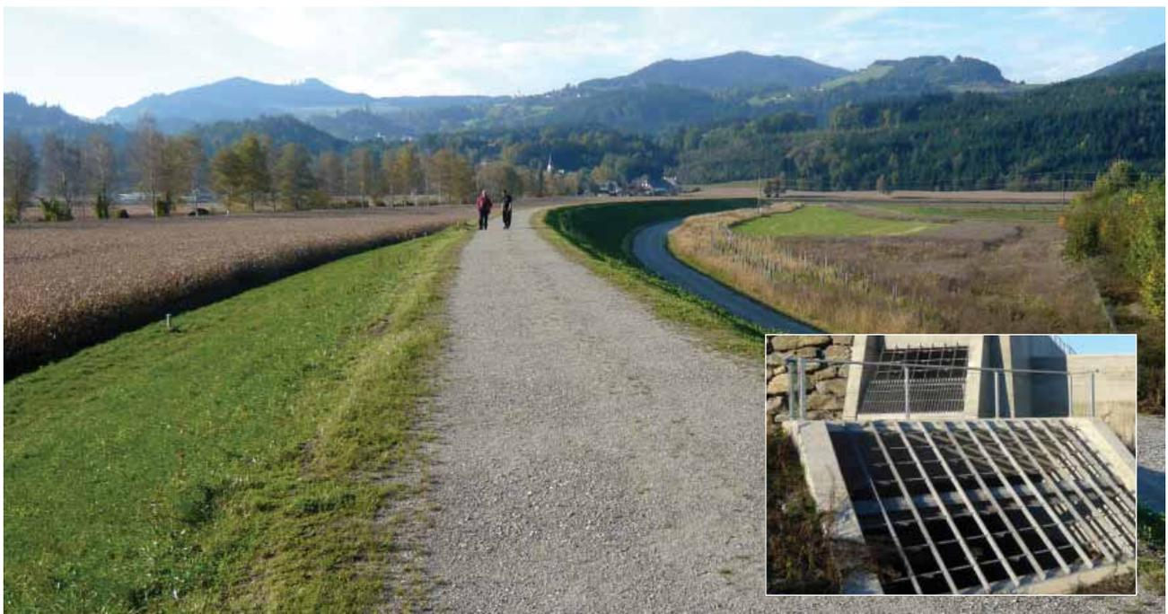
▲ Zum Rückhaltebecken Seidelhof gehört ein 1,4 km langer und rund 5 m hoher Damm quer zum Glantal. Über eine Wehranlage (li. o.) können bis zu 3,5 Mio. Kubikmeter Wasser zurückgehalten werden.
