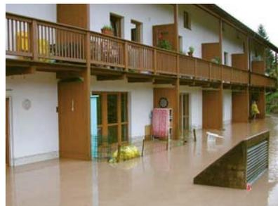
**Schwachstelle Lüftungsschacht.** Über den nicht gesicherten Lüftungsschacht (re.) strömt das Wasser in die darunterliegende Tiefgarage.
