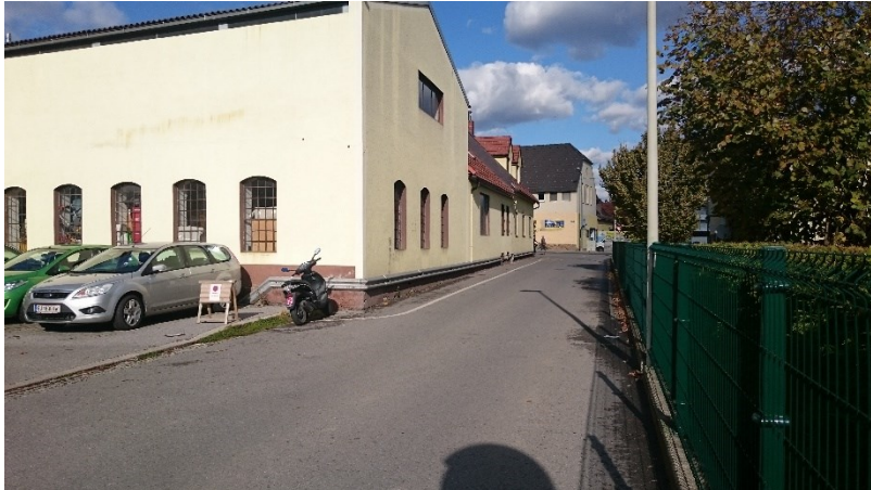
Foto 1: Aribonenstraße im Bestand im Abschnitt Gradner Straße bis zum Bestandsgehsteig beim Caritas Wohnheim, Blickrichtung Norden
