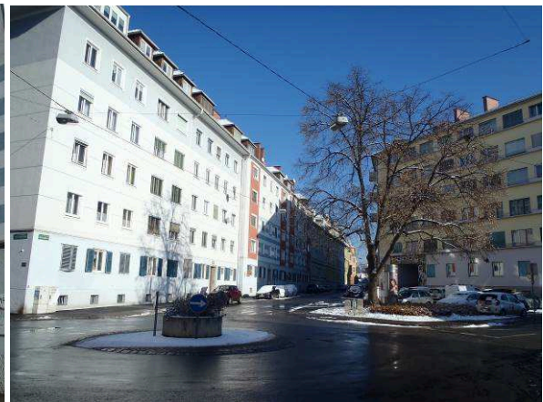
Foto 2: Krenngasse: Blick Richtung Nordosten Links Häuser Krenngasse 1, 3, 5 bis 15
