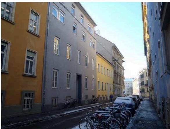
Foto 7: Schützenhofgasse – Blick Richtung Südwesten, mittig gelbes Haus Nr. 12
