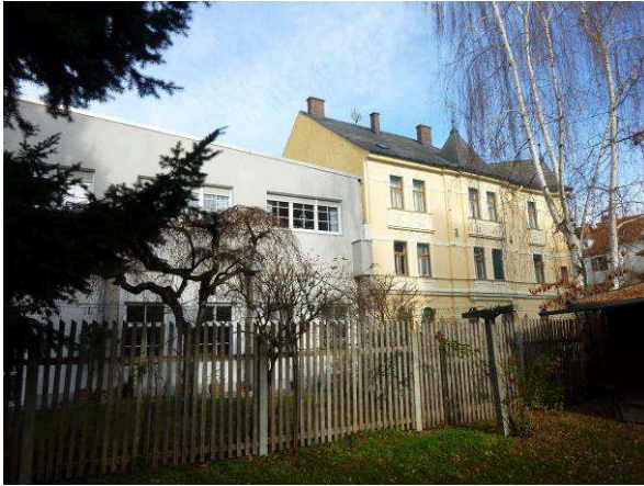
Foto 9: Blick vom Innenhof Richtung Norden: Herrandgasse 7 und 9
