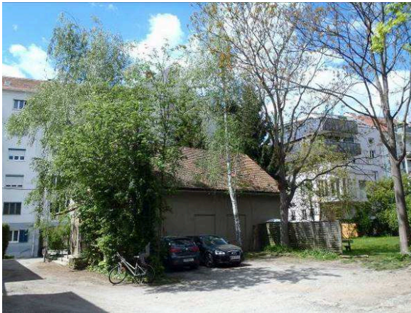
Foto 11: Blick vom Innenhof Richtung Westen auf das „Kistl“ (ehemalige Garage der Wagen- fabrik Gustav Koller) – (nicht schutzwürdiger Bestand laut ASVK)
