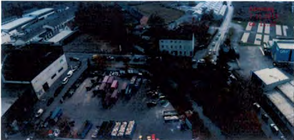
Typische Stausituation in der Puchstraße / Sturzgasse durch Recycling Center-Nutzer
