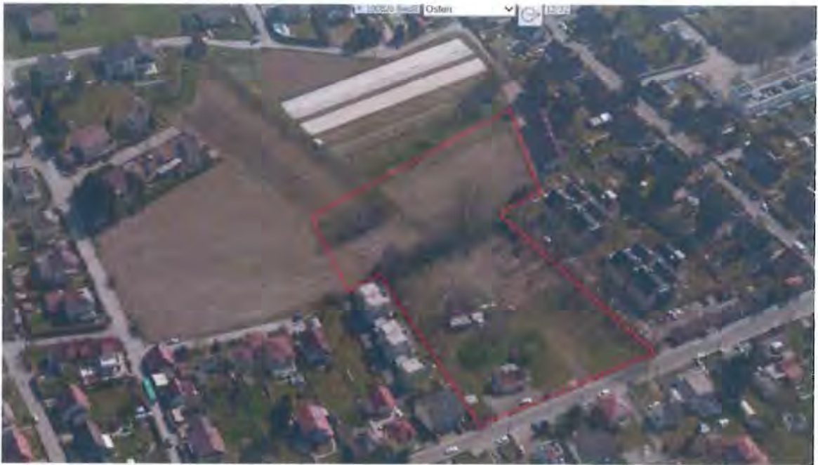
Luftbild 2 (2015) Schrägaufnahme, ©Stadt Graz – Stadtvermessung. Blick in Richtung Osten. Die rot punktierte Umrandung markiert in etwa das Planungsgebiet.
