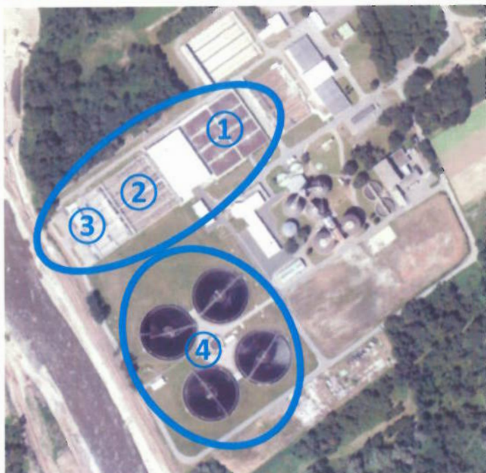
Abbildung 4: Standort Biologische Reinigungsstufe Quelle: HG-WW bzw. Stadtvermessungsamt
