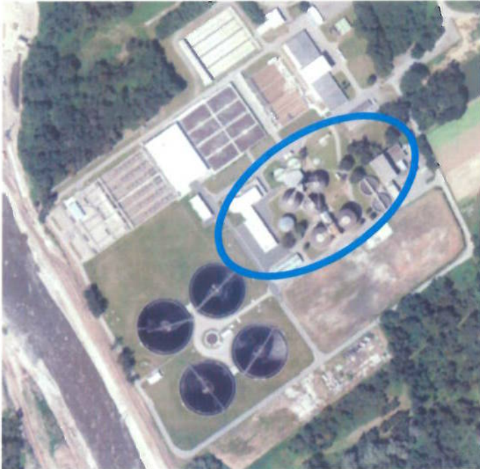
Abbildung 5: Standort chlammbehandlung Quelle: HG-WW bzw. Stadtvermessungsamt
