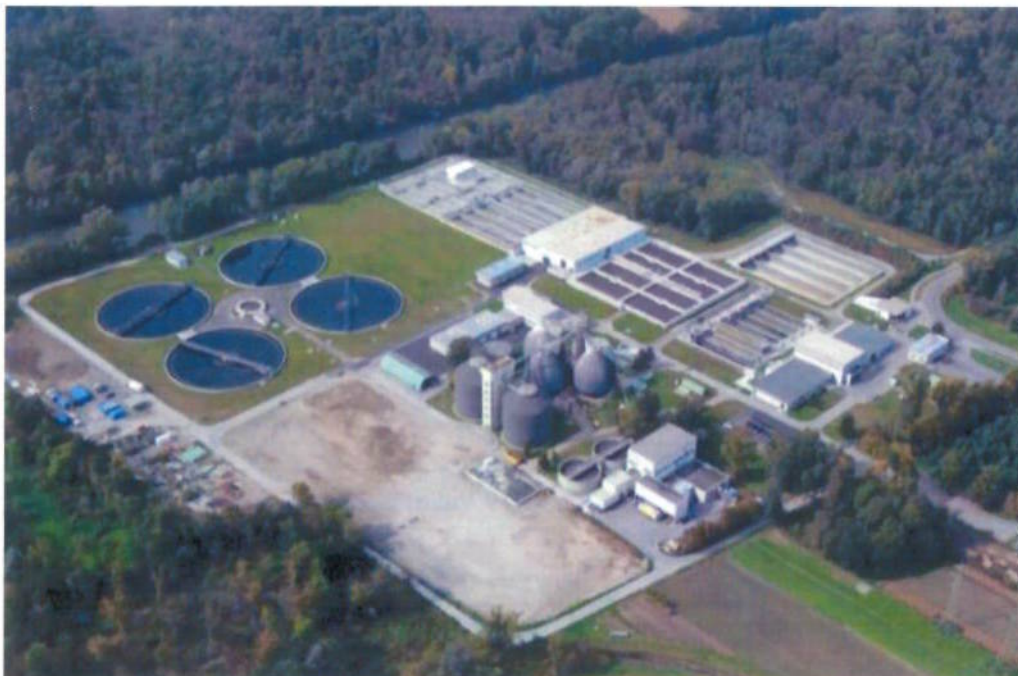
Abbildung 1: Standort und Luftbild Kläranlage der Landeshauptstadt Graz in Gössendorf Quelle: Stadtvermessungsamt bzw. HG-WW
