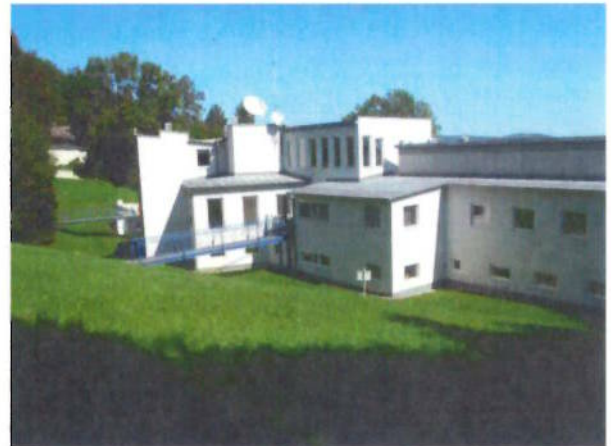
Foto 2: Kastanienhof Blick in nordöstliche Richtung.
