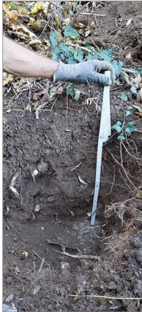
Abb. 17: Aushub bis ca. 46 cm unter GOK
