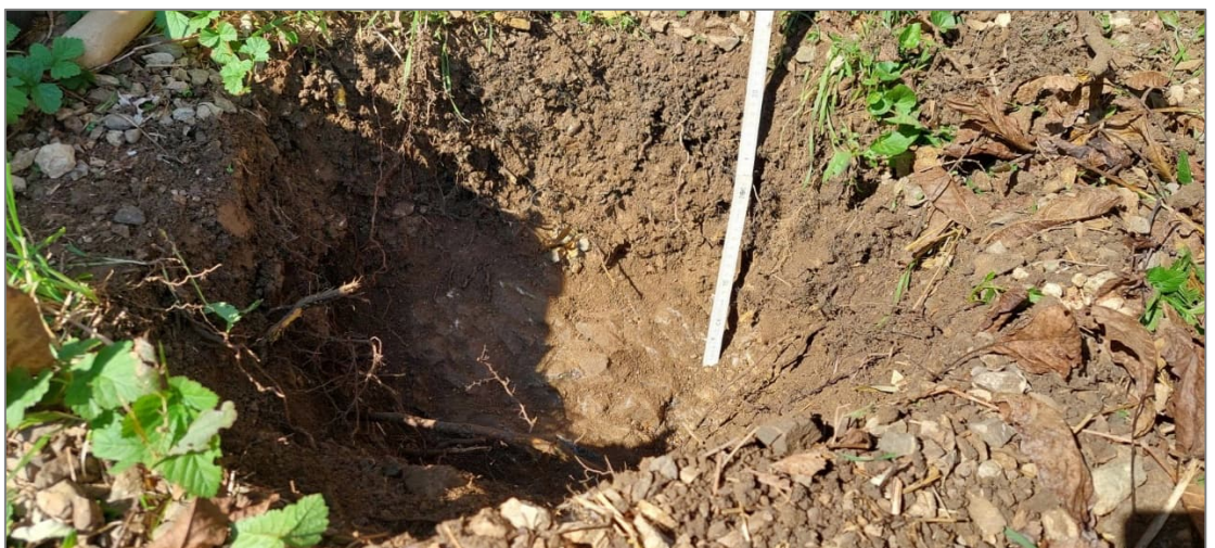
Abb. 6: Aushub bis ca. 35 m unter Geländeoberkante (GOK)
