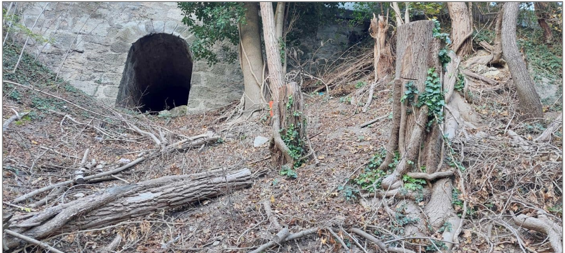
Abb. 8: Blick Richtung nördliche Grundstücksgrenze (Durchlass Steinbergstraße)
