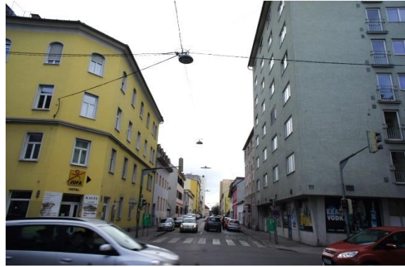
Foto 2: Kreuzung Josef-Huber-Gasse - Idlhofgasse Blick Richtung Süden.
