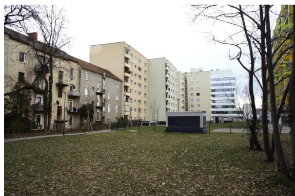
Foto 7: Innenhofbereich des Gevierts Blick Richtung Idlhofgasse - Richtung Süden.
