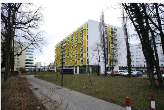
Foto 7: Innenhofbereich des Gevierts Blick Richtung Eggenberger Gürtel - Richtung Südosten.
