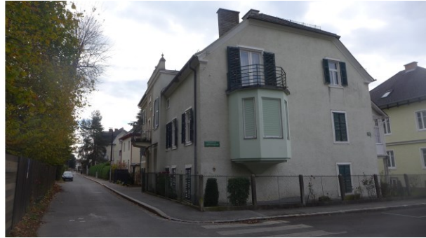
Foto 4: Siemensgasse 18/6: Blick Rapoldgasse von Nord nach Süd Richtung Ruckerberggasse
