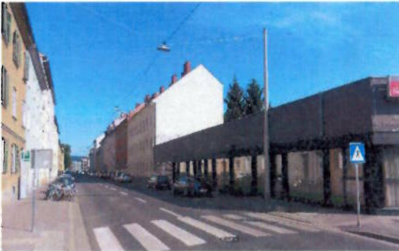
Foto 7: Kreuzung Hackhergasse/Kalvarienbergstraße Blick Richtung Norden
