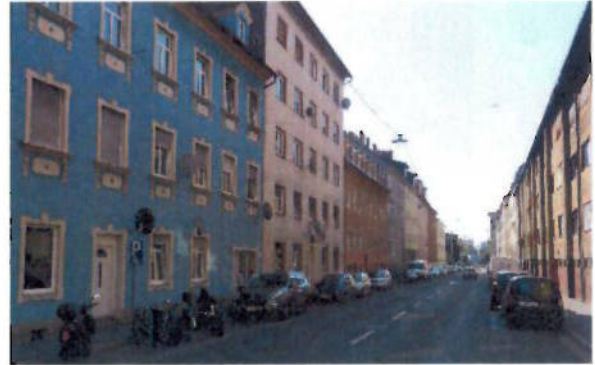
Foto 8: Hackhergasse Höhe Hausnr. 30 Blick Richtung Südosten
