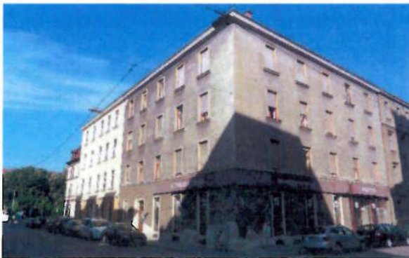
Foto 1: Kreuzung Grimmigasse/Austeingasse Blick Richtung Nordwesten
