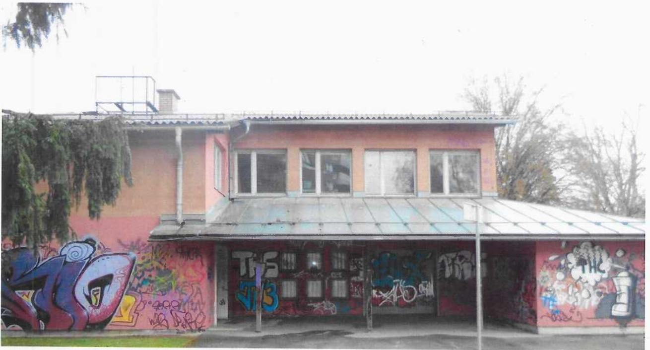
Abb. 2.: Der bestehende Stützpunkt wird abgebrochen.
