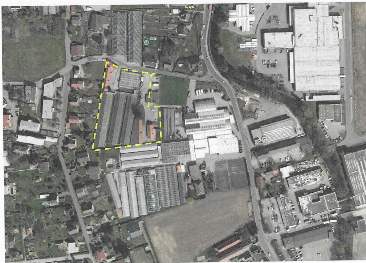
Luftbild 1: Schrägluftbild (2015) #: 101248 Vogelperspektive, Aufnahme©Stadt Graz – Stadtvermessung Der gelb strichlierte Rahmen kennzeichnet das Bebauungsplangebiet.
