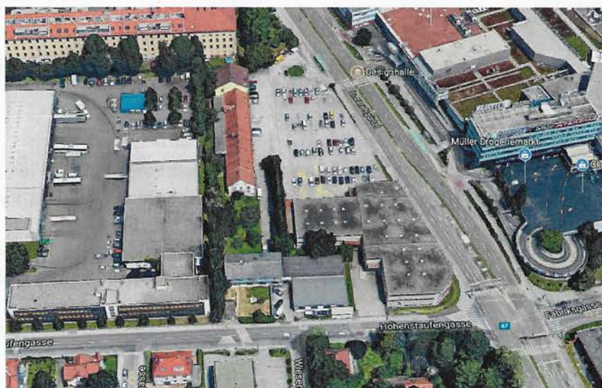
Luftbild/ Schrägaufnahme (2007): Blick in nördliche Richtung. Die gelben Pfeile bezeichnen das Baugebiet - Areal
