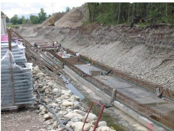
Bodenplatte Ortbeton HSEK
