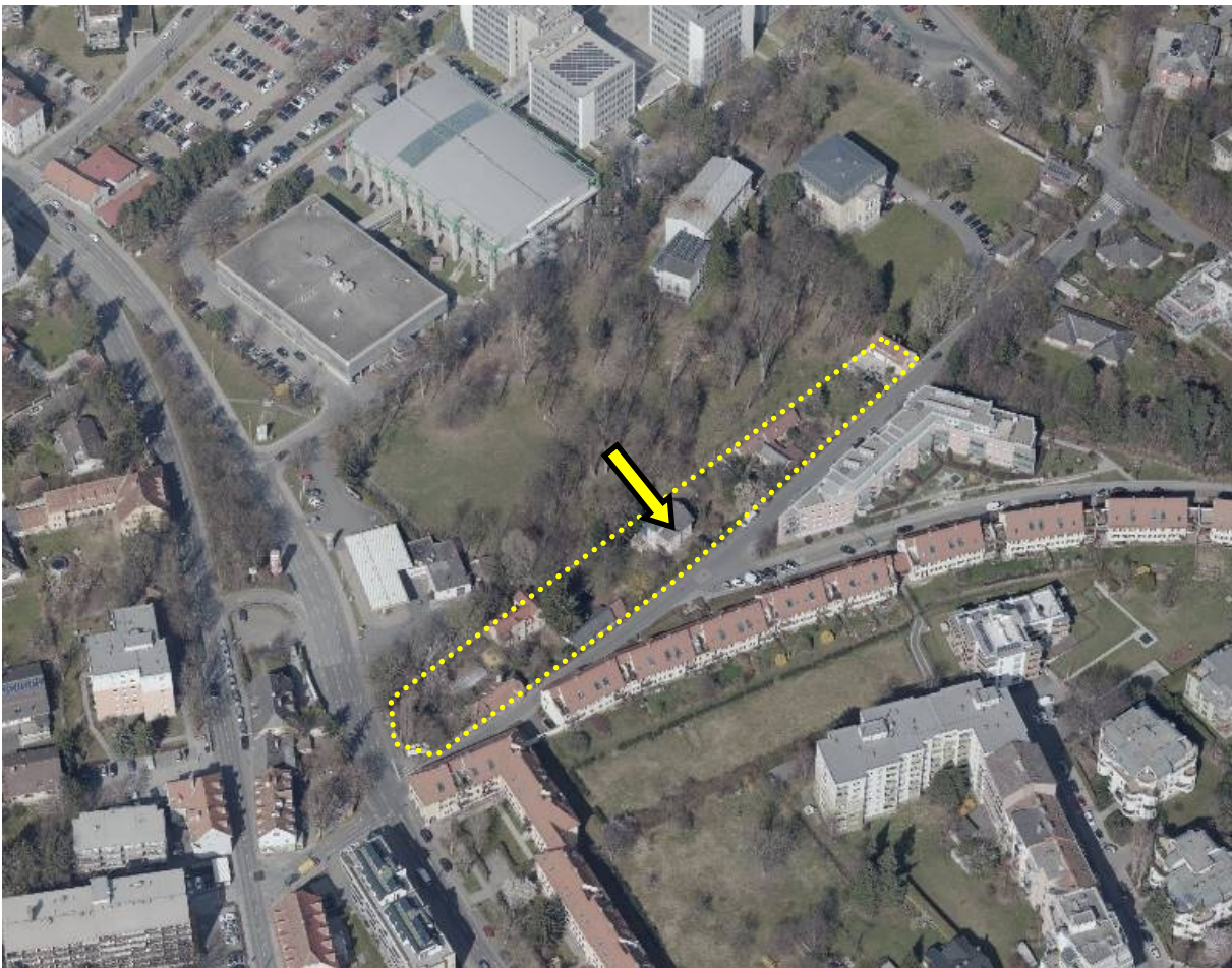
Schrägaufnahme: Blick in nördliche Richtung. Der gelbe Pfeil bezeichnet das Planungsgebiet.
