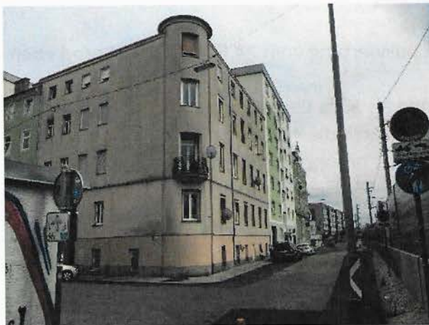
Foto 1: Kreuzung Bessemergasse - Prankergasse: Blick Richtung Süden.
