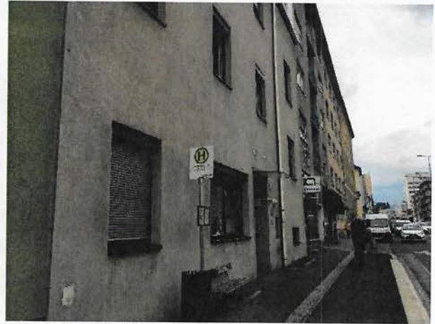
Foto 6: Eggenberger Gürtel 36 mit Bushaltestelle vor dem Haus; Blickrichtung Norden.
