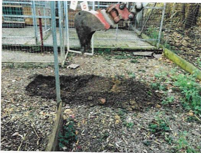
Abb. 25: S15/19 Aushub (Foto: UTC)
