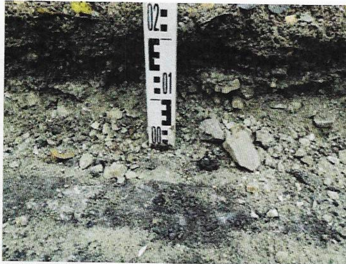
Abb. 11: S7/19 Schurfsohle und -wand
