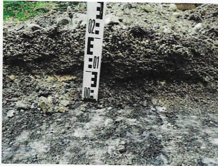
Abb. 8: S5/19 Schurfsohle und -wand
