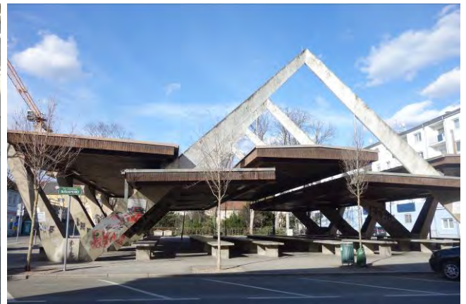
Foto 2: Blick in nördliche Richtung von der Krausgasse auf den Hofbauerplatz mit der denkmalgeschützten Überdachung für den Markt
