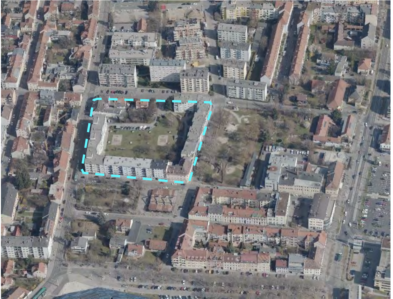
Luftbild 3, Quelle: Schrägluftbild #: 3595, Aufnahme©Stadt Graz – Stadtvermessung Blick Richtung Osten. Der Rahmen kennzeichnet das Bebauungsplangebiet, links führt die Georgigasse von Ost nach West, rechts davon ist die Spielplatzfläche in Freiland zu sehen, im oberen Bildbereich sind die Großstrukturen der Geschossbauten die sich östlich der Bebauungsplangebietes befinden zu sehen
