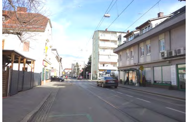
Foto 10: Blick in östliche Richtung entlang der Georgigasse, rechts die Liegenschaft Georgigasse 25, dahinter der sechsgeschossige Wohnbau an der Vinzenzgasse 22
