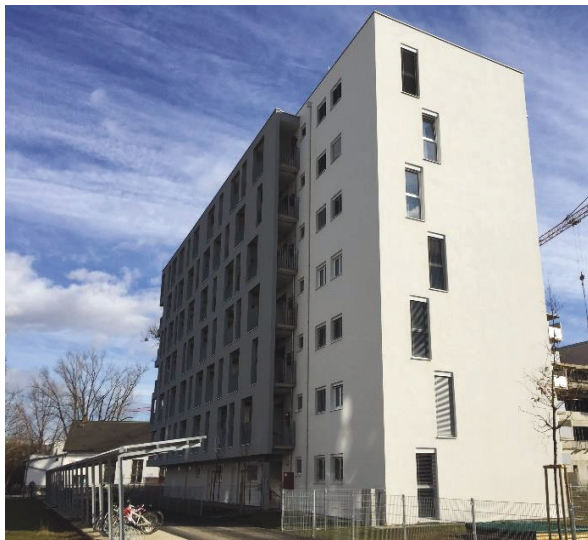
Abbildung 11: Neubauprojekt Waagner-Biro-Strasse 49, 49a © Wohnen Graz
