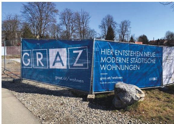
Abbildung 13: Der Baustart Am Grünanger ist erfolgt © Wohnen Graz
