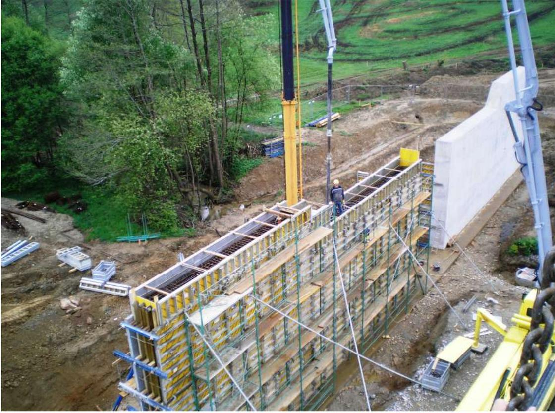
*Foto: Schalungsarbeiten für das Sperrenbauwerk*
