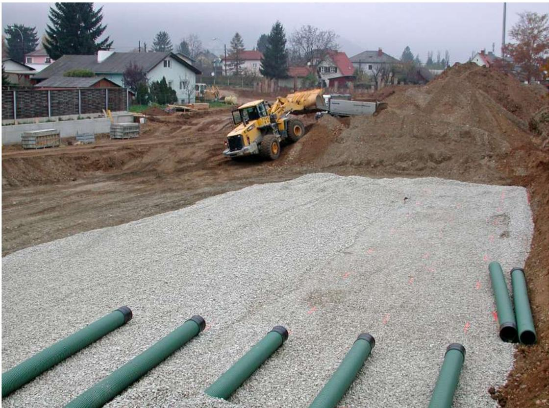
*Foto: Die aufwendige Verlegung des unterirdischen Drainagerohrsystems*
