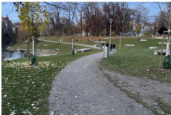
Abbildung 64: Versickerungsfähige Gehwegoberfläche Augartenpark
