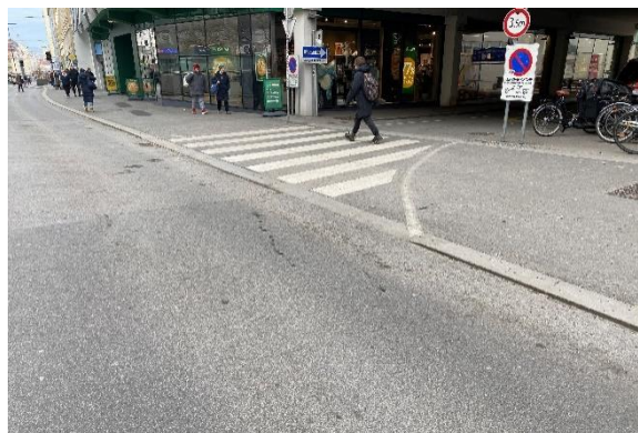
Abbildung 44: Gehsteigauffahrt Annenstraße Zufahrt Leiner
