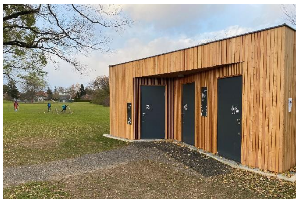
Abbildung 68: WC-Anlage ORF Park
