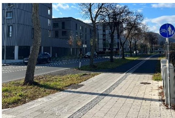
Abbildung 46: Getrennter Geh- und Radweg in der Wetzelsdorfer Straße. Ein breiter, gepflasterter Gehweg verläuft parallel zu einem asphaltierten Radweg, getrennt durch eine Grünanlage mit Bäumen.
