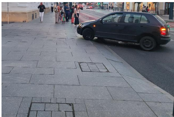
Abbildung 43: Durchgezogener Gehsteig, Cluj-Napoca
