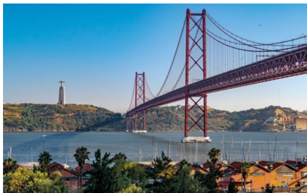
25 de Abril Bridge, Tagus River
