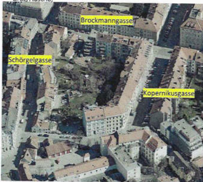
Luftbild/Schrägaufnahme Blick Richtung Osten: Microsoft Company © / Vexcel Imaging GmbH, Graz/Austria,
