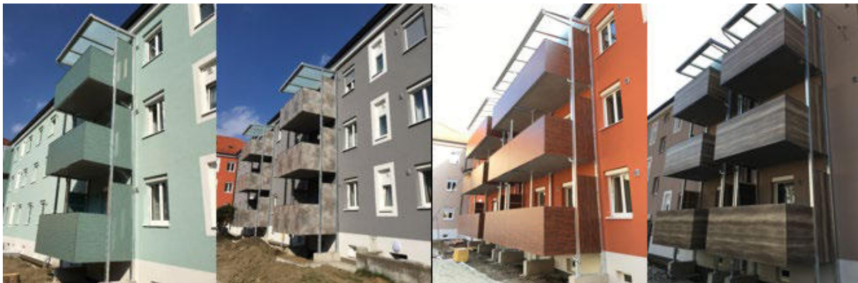
Abbildung 59: Thermische Sanierung in der Triester-Siedlung © Wohnen Graz
