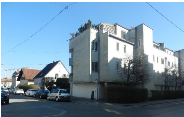
Abbildung 5: Kreuzung Gaswerkstraße/Königshoferstraße Blick Richtung Südosten
