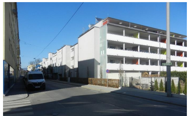
Abbildung 6: Kreuzung Gaswerkstraße/Bauernfeldstraße Blick Richtung Nordosten
