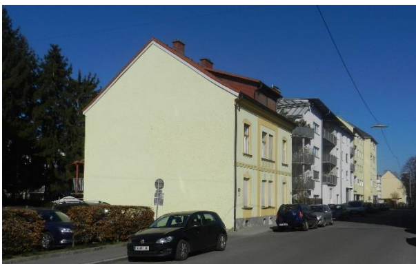
Abbildung 13: Blick auf die Bebauung Bauernfeldstraße 32 in Richtung Nordosten
