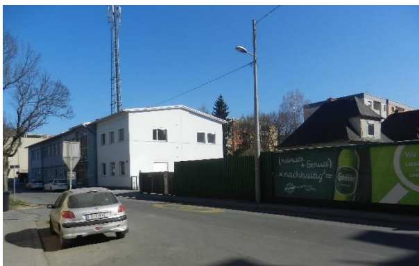
Abbildung 9: Blick vom Kreuzungsbereich Königshoferstraße/ Karl-Morre-Straße in Richtung Südosten
