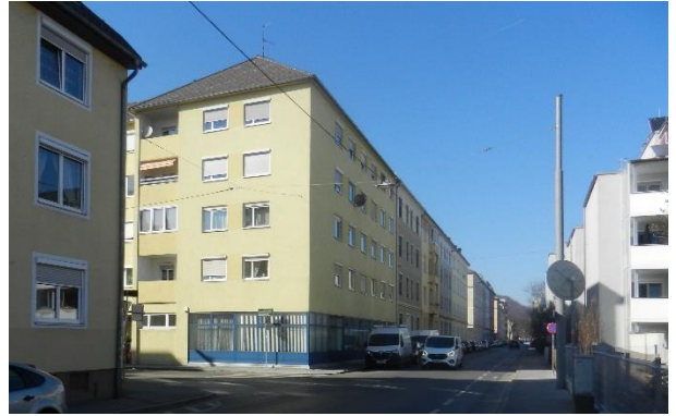
Abbildung 12: Blick vom Kreuzungsbereich Gaswerkstraße/ Bauernfeldstraße in Richtung Nordwesten
