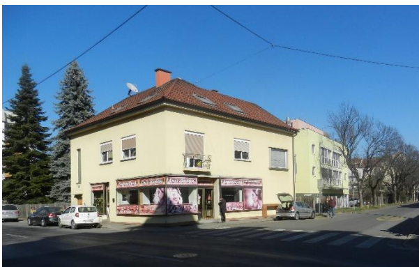
Abbildung 1: Kreuzung Königshoferstraße/Karl-Morre-Straße Blick Richtung Nordosten
