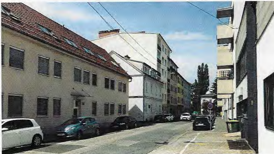
Foto 3: Blick in nördliche Richtung entlang der Lagergasse auf Höhe der Haus-Nr. 57.
