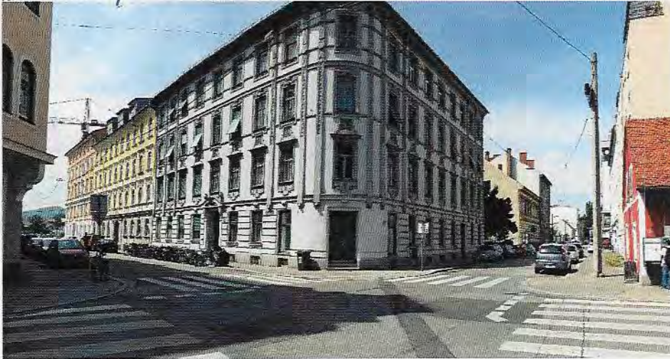
Foto 1: Blick in nordwestliche Richtung im Kreuzungsbereich Lagergasse – Hermann-Bahr- Gasse.
