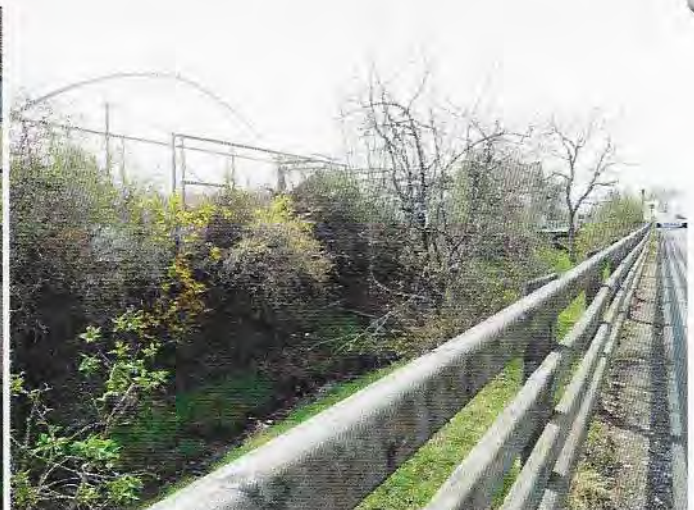
Foto 6: Blick in westliche Richtung entlang des Petersbaches und des Geh- und Radweges entlang der nördlichen Böschung des Petersbaches
