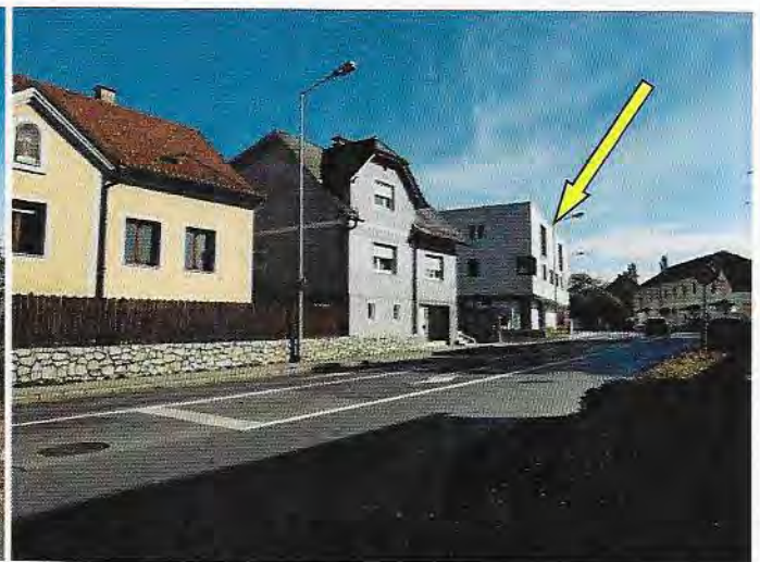
Foto 8: Blick in südöstliche Richtung, links im Vordergrund ist das Gebäude an der Liebenauer Hauptstraße 81 zu sehen, weiter rechts die Liegenschaft Liebenauer Hauptstraße 83 und rechts der Neubau Liebenauer Hauptstraße 85 (gelber Pfeil)
