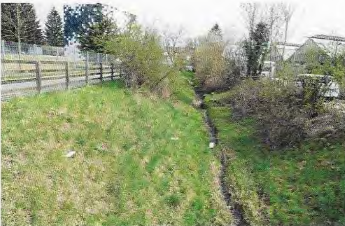
Foto 20: Blick in östliche Richtung entlang des Petersbaches, rechts nach dem Uferfreihaltebereich im Freiland der nordwestliche Teil des Bebauungsplangebiets
