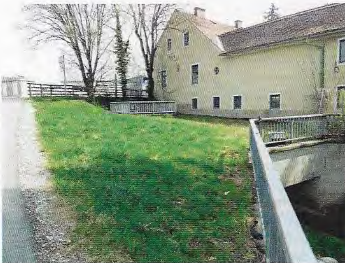
Foto 5: Blick in östliche Richtung auf den Bereich der Verrohrung des Petersbaches; rechts im Bild die Liegenschaft Liebenauer Hauptstraße 84
