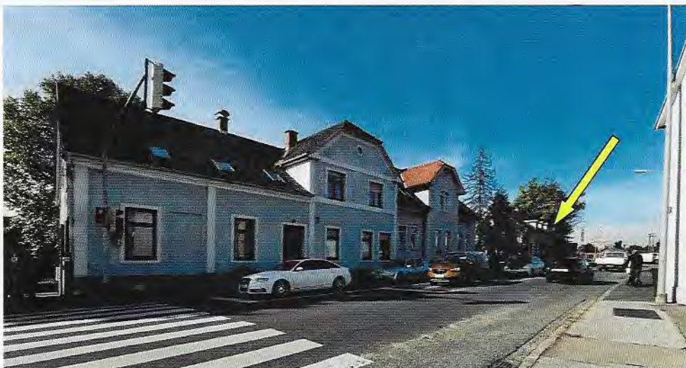
Foto 1: Blick in nordwestliche Richtung auf die Bebauung an der Liebenauer Hauptstraße. Von rechts nach links, die Liegenschaften Liebenauer Hauptstraße 84 (siehe gelber Pfeil), Liebenauer Hauptstraße 86 und Liebenauer Hauptstraße 88
