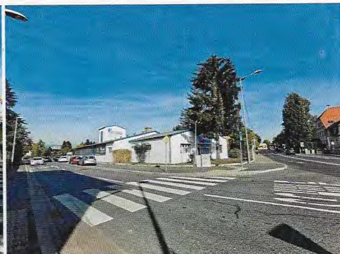
Foto 13: Blick in nordöstliche Richtung auf den Kreuzungspunkt Puntigamer Straße / Raiffeisenstraße und den eingeschossigen Hallenbau eines Unternehmens der Puntigamer Straße 14
