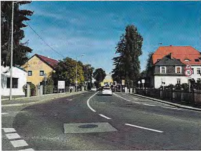
Foto 14: Blick in östliche Richtung entlang der Puntigamer Straße, rechts im Hintergrund die Wohnbebauung der Liegenschaft Puntigamer Straße 7, dahinter ist das Gebäude der Volksschule Graz-Liebenau zu sehen. Links im Bild die Liegenschaft Puntigamer Straße 10 im Bereich des Bebauungsplangebiets
