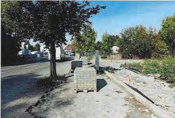
Foto 18: Blick in nordöstliche Richtung entlang der Raiffeisenstraße
